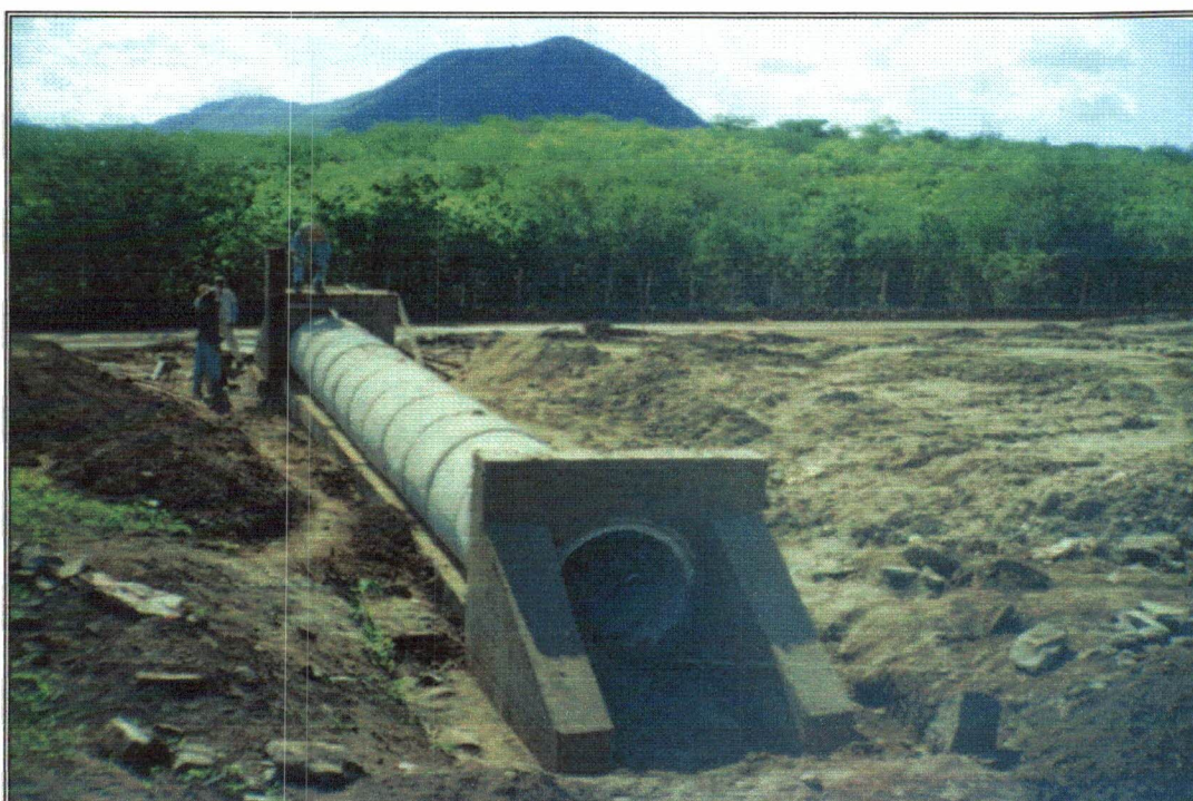
Foto 18 – Bueiro BSM, situado na estaca 184,00.
