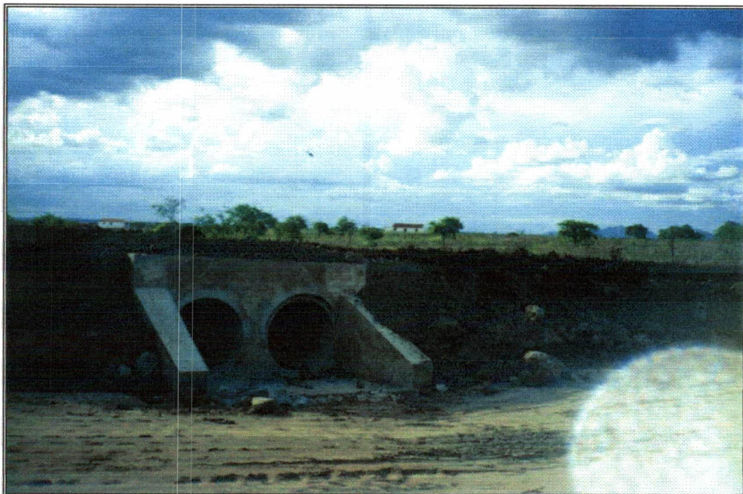
Foto 32 – Colocação do aterro sobre bueiro BDM.
