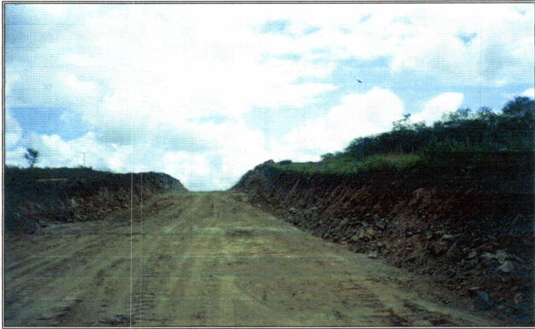
Foto 23 – Aspecto de um trecho em corte, com materiais de 2ª e 3ª categorias.
