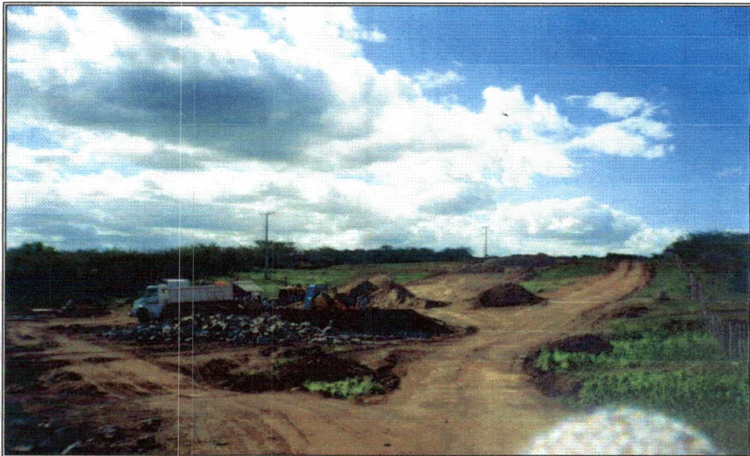
Foto 14 – Canteiro de obra, para construção das obras d'Art.
