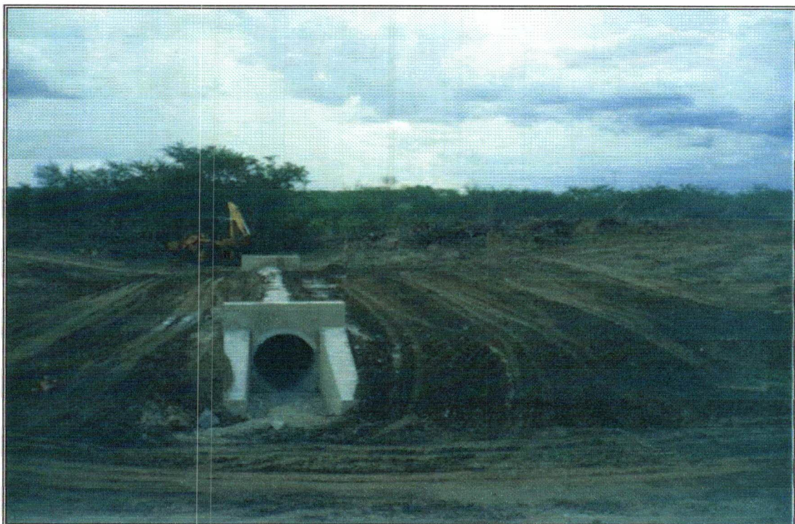
Foto 20 – Bueiro BSM, situado na estaca 231+5,30.
