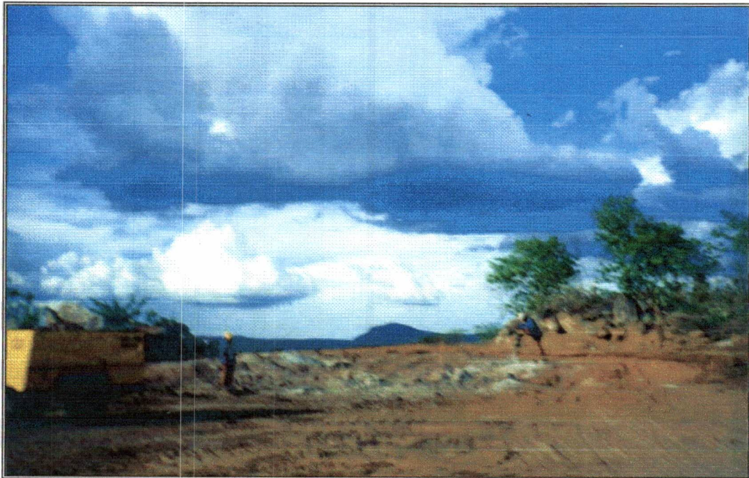
Foto 07 – Compressor e marteletes pneumáticos preparando furos para explosão material de 3ª categoria.
