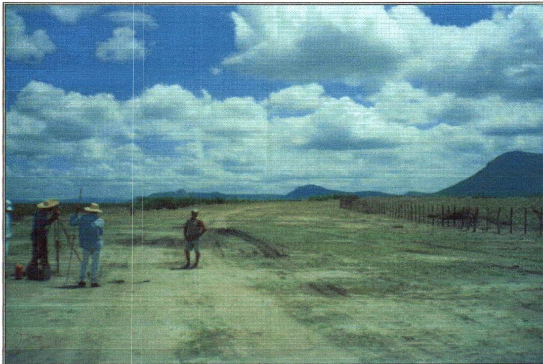
Foto 01 – Locação da estrada de contorno (desvio na estrada Quixeramobim – Madalena).
