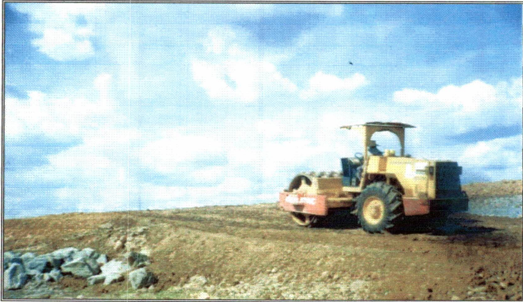
Foto 27 – Compactação com rolo vibratório pneumático.
