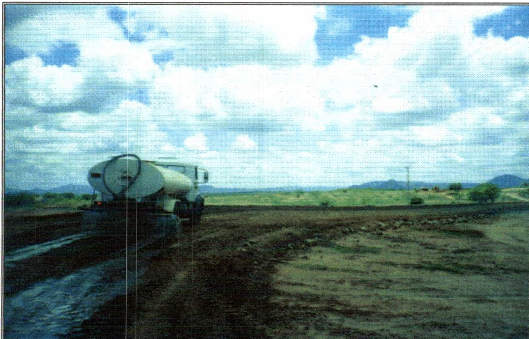
Foto 12 – Umedecimento do material para compactação.
