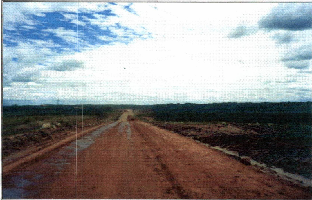
Foto 35 – Preparação do leito da estrada para receber o revestimento primário.
