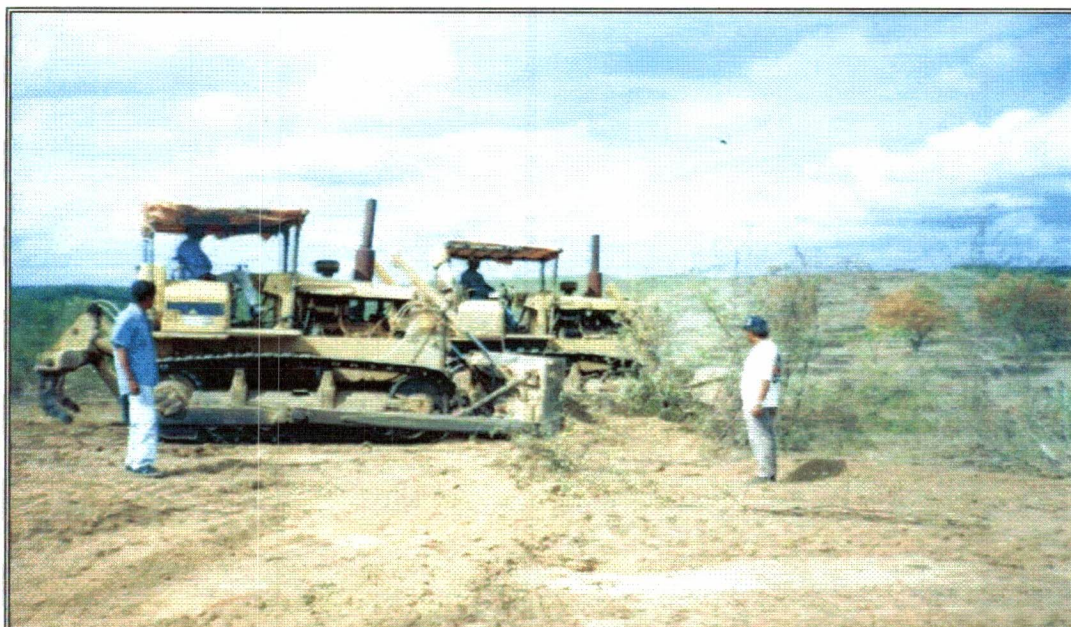
Foto 06 – Tratores trabalhando no desmatamento e expurgo.
