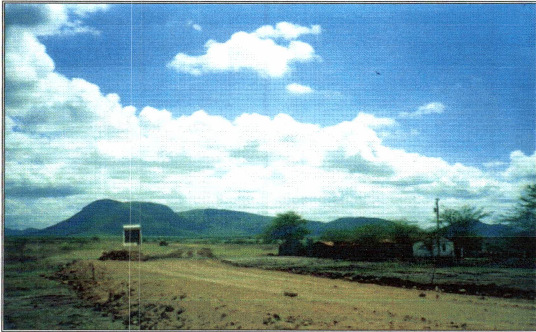
Foto 11 – Colocação de material para posterior homogeneização.
