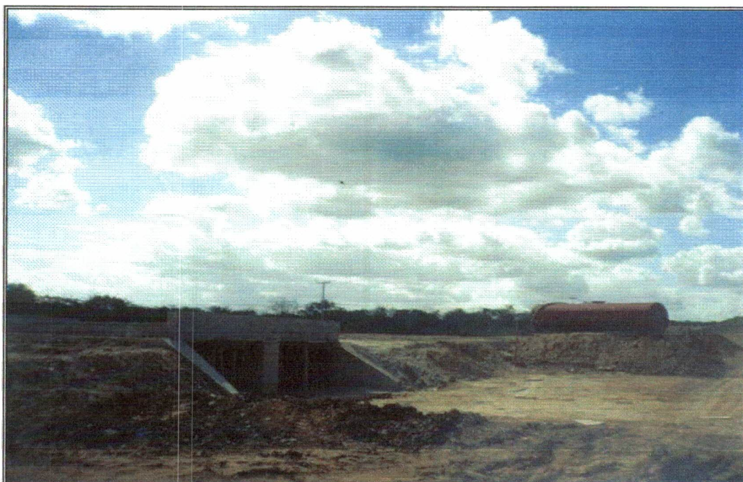
Foto 34 – Bueiro duplo capeado (BDC) na estaca 312,00+5,00.
