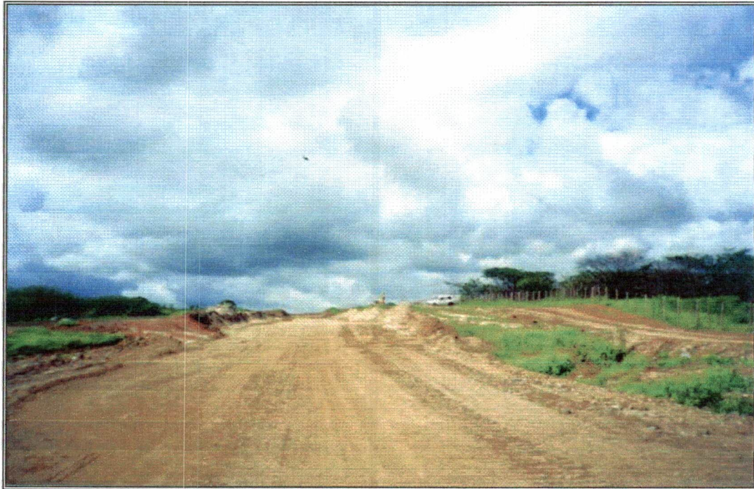
Foto 33 – Vista panorâmica da estrada em obras.
