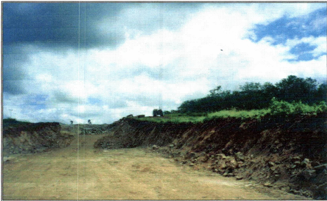
Foto 24 – Aspecto de um trecho em corte, com materiais de 2ª e 3ª categorias.
