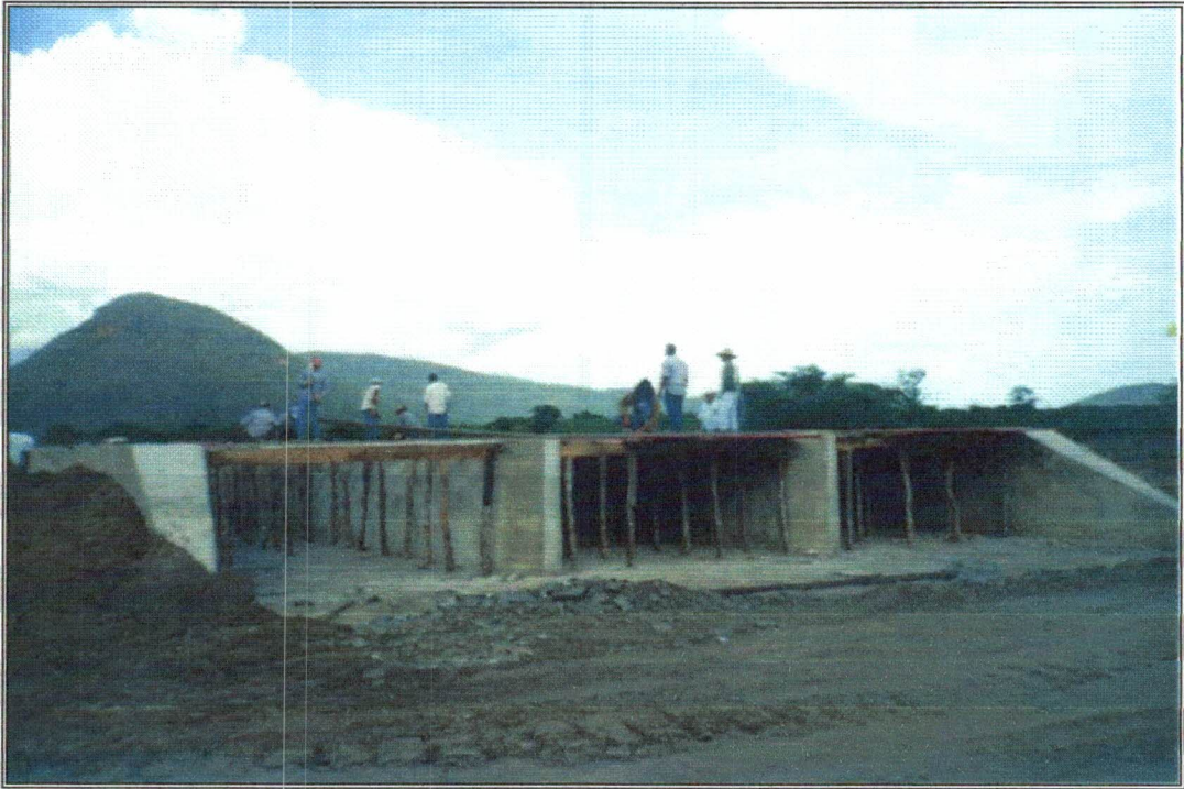
Foto 19 – Bueiro BTC, situado na estaca 208,00.
