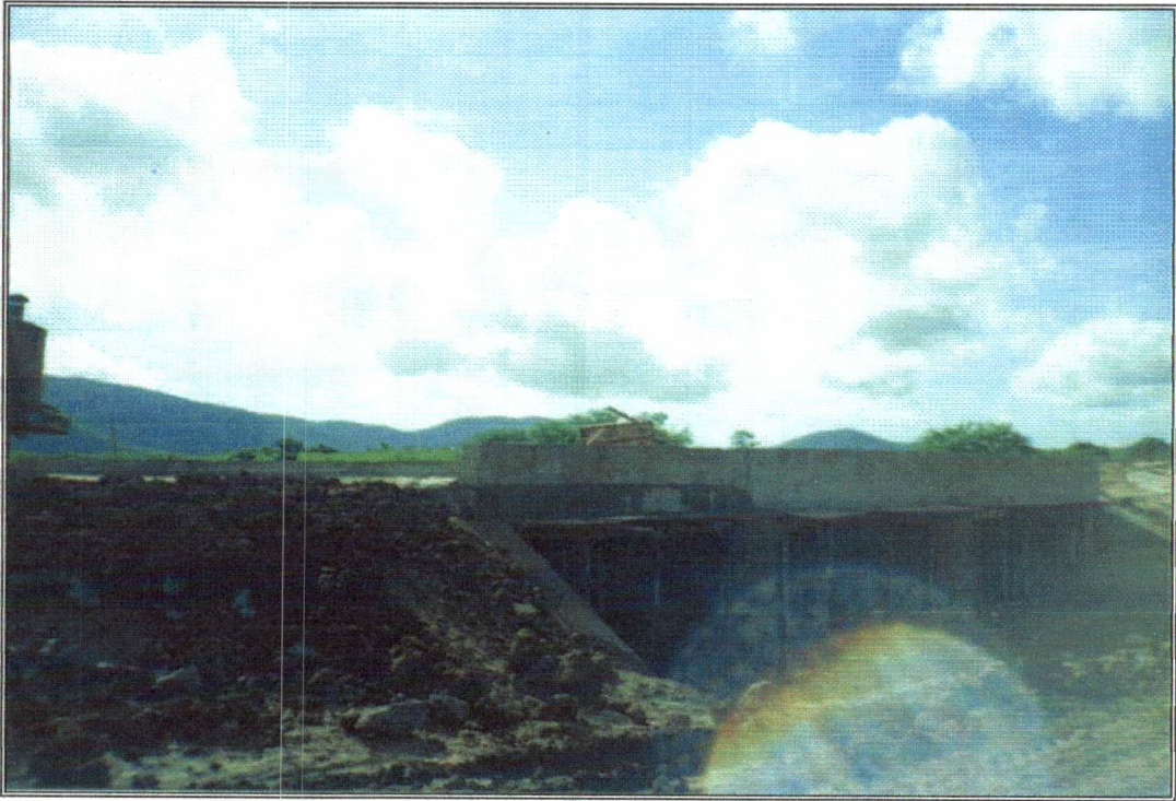
Foto 21 – Bueiro BTC, situado na estaca 293+14,00.
