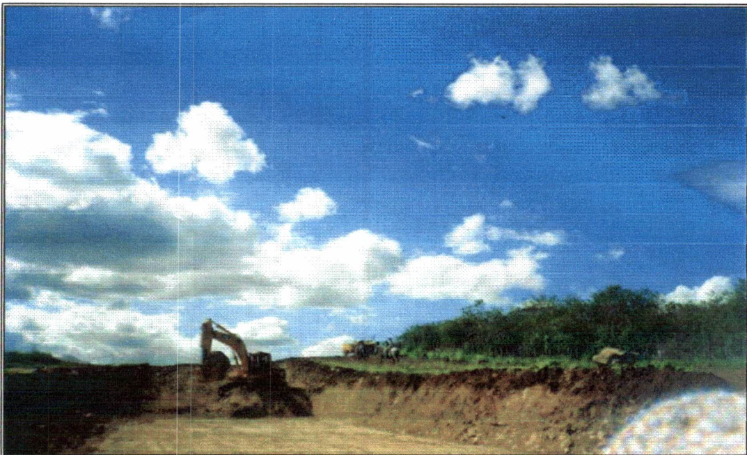
Foto 16 – Abertura de corte com utilização de escavadeira hidráulica.
