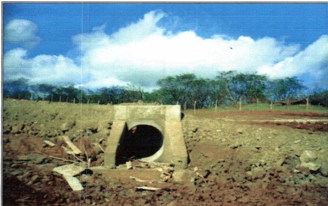
Foto 29 – Boca de Bueiro BSM, logo após conclusão.
