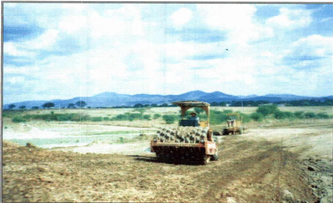
Foto 28 – Compactação com rolo vibratório pneumático.
