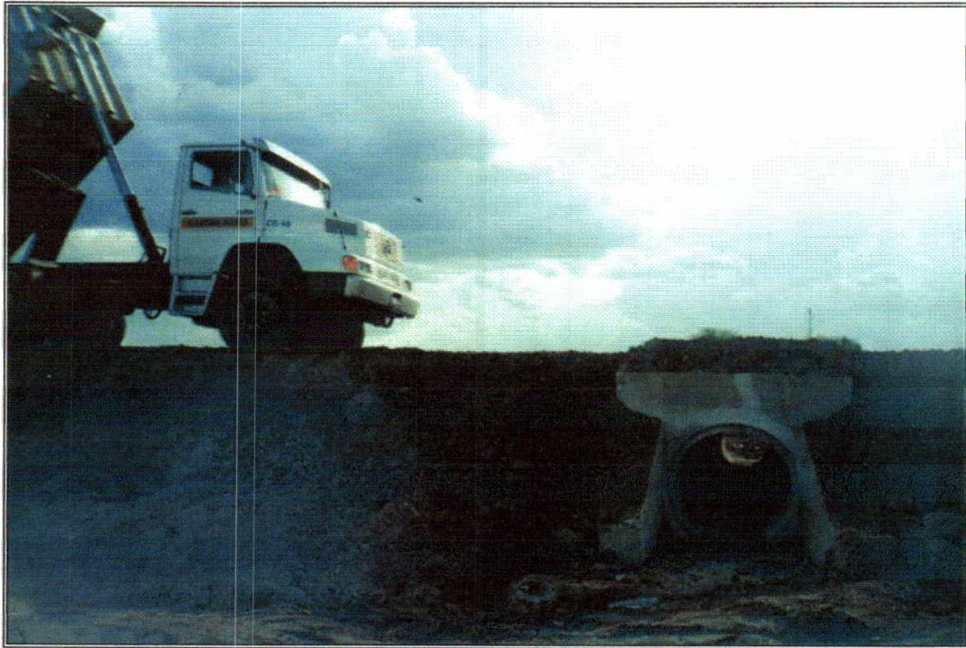
Foto 31 – Aterro junto a bueiro BSM.
