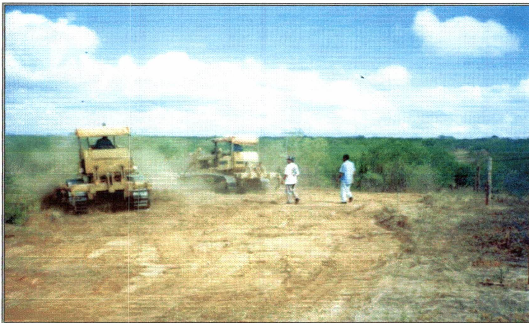
Foto 05 – Tratores trabalhando no desmatamento e expurgo.
