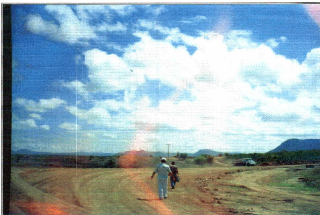
Foto 02 – Início do Desvio na Rodovia CE – 166.
