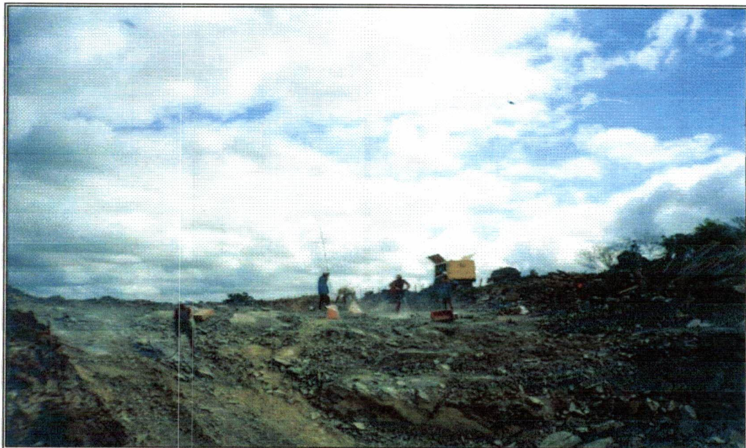
Foto 08 – Compressor e marteletes pneumáticos preparando furos para explosão material de 3ª categoria.
