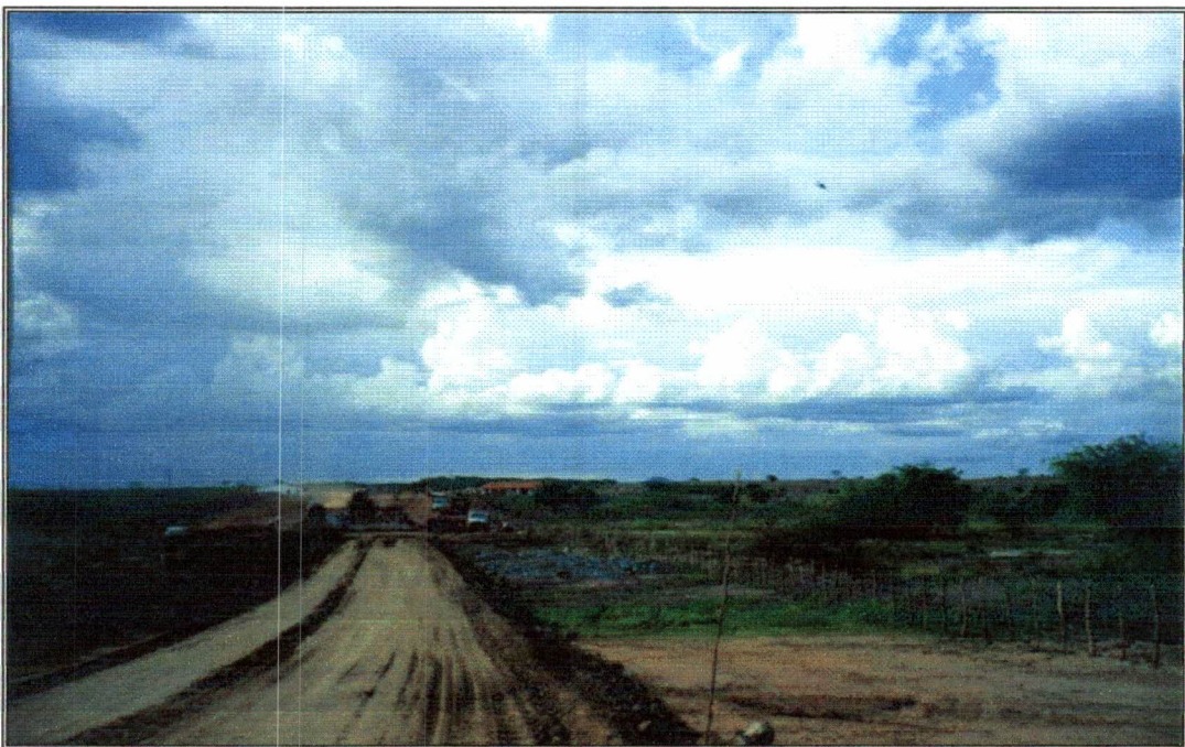
Foto 10 – Colocação de material terroso após expurgo do terreno.
