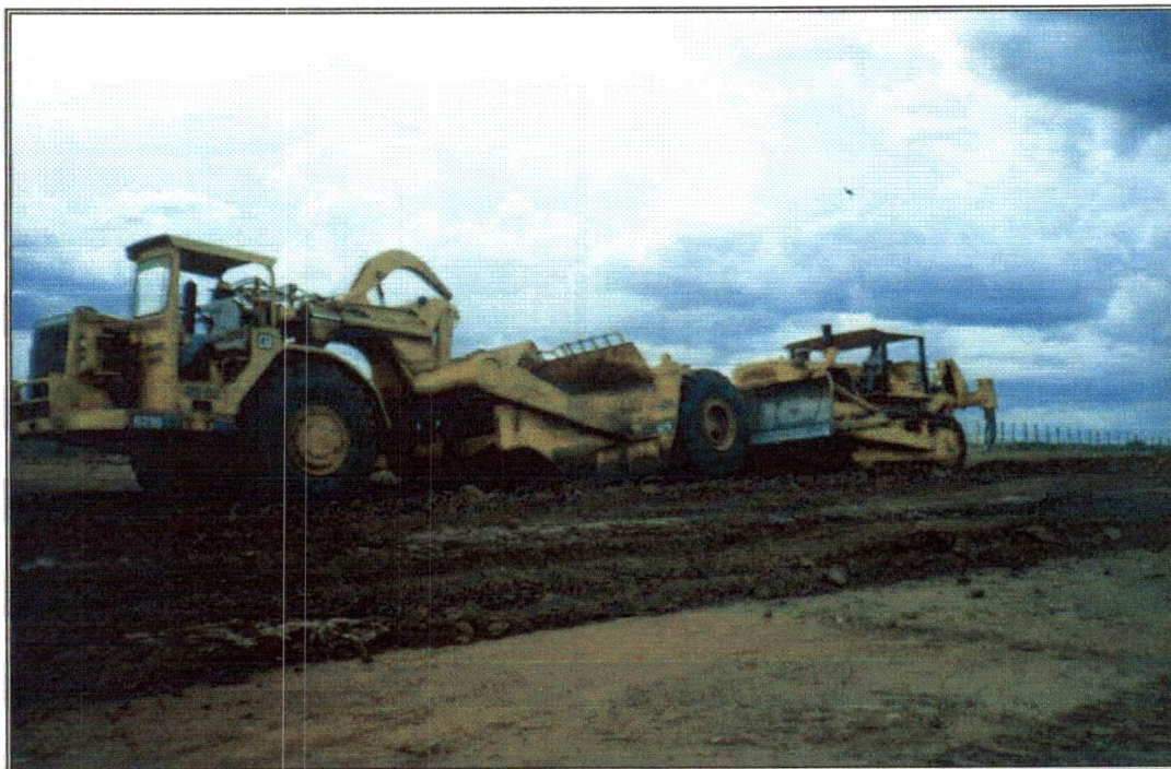
Foto 03 – Expurgo de material inservível, com a utilização de moto-scraper e trator.
