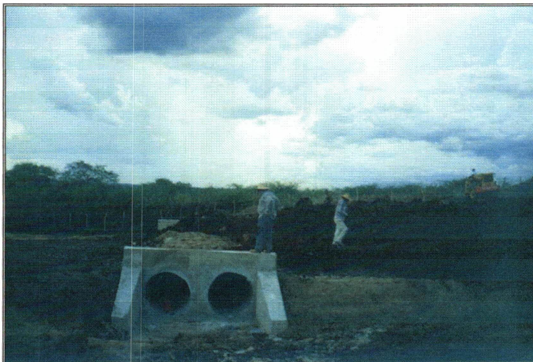
Foto 17 – Bueiro BDM, situado na estaca 163+8,00.
